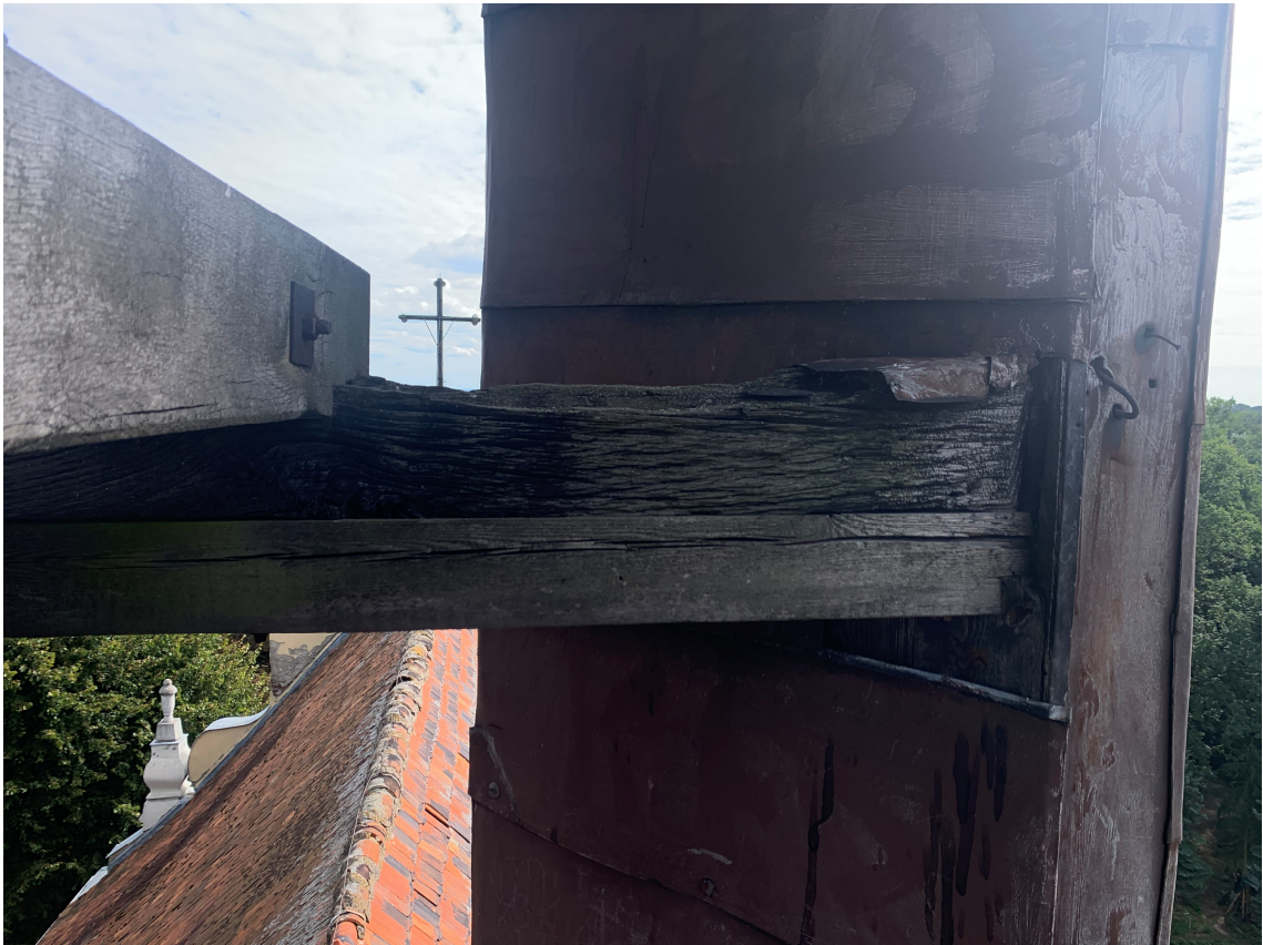
uszkodzenie elementów konstrukcji drewnianej wieży-sygnaturki
