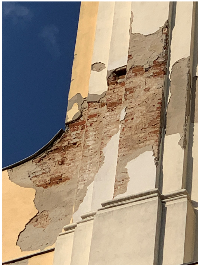
ubytki na elewacji frontowej
