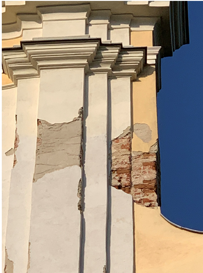
ubytki na elewacji frontowej
