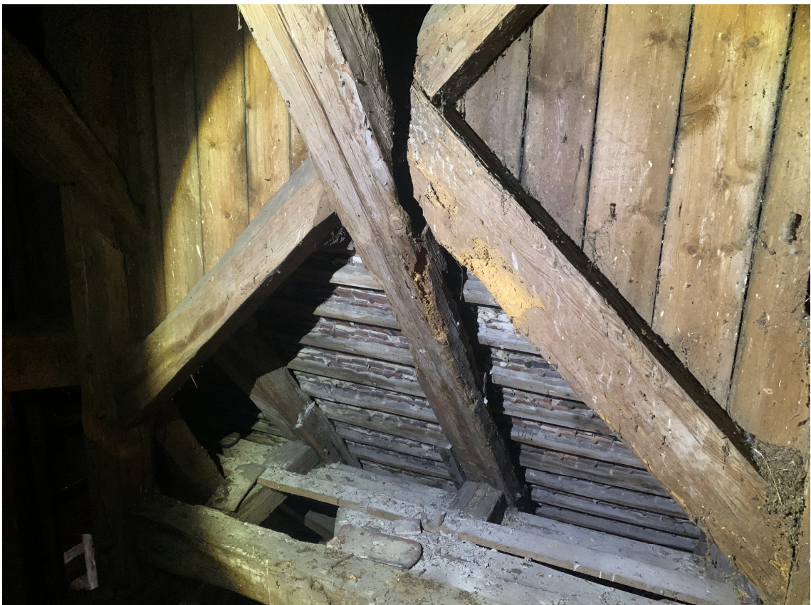
uszkodzenie elementów konstrukcji drewnianej wieży-sygnaturki
